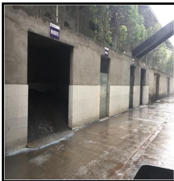
储存区三防建设及标识牌
